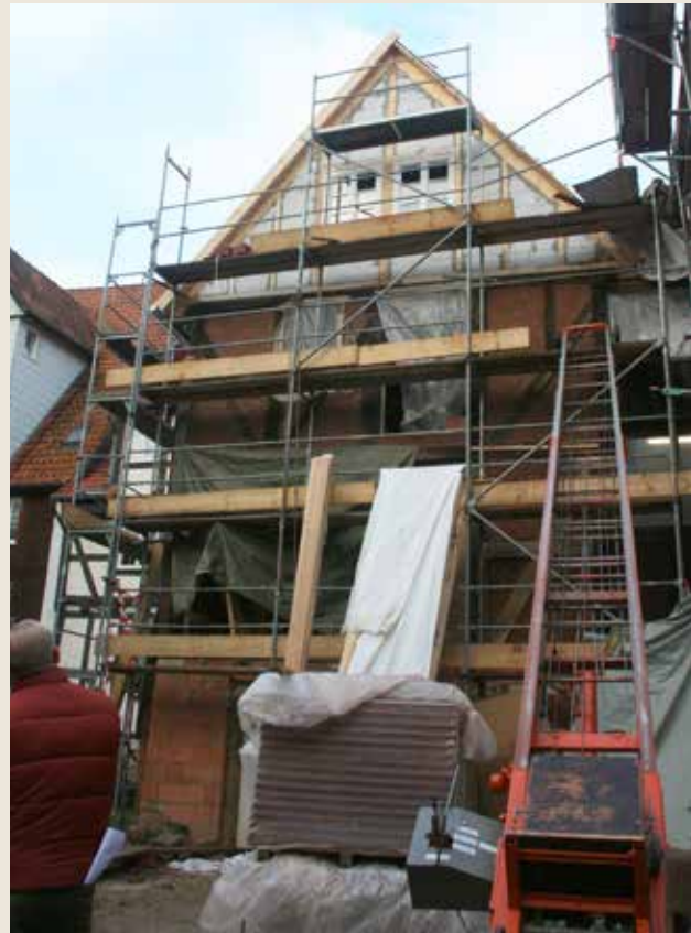
Die Bürgergenossenschaft Mündener Altstadt sanierte damals das Fachwerkhaus in der Speckstraße 7 in Hann. Münden.
