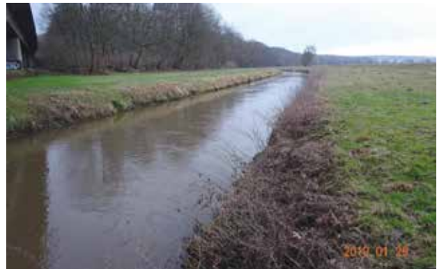
Die Leine vor Beginn der Renaturierungsmaßnahmen: der Fluss war lediglich ein monotoner Wasserabflusskanal. Foto: Leineverband
