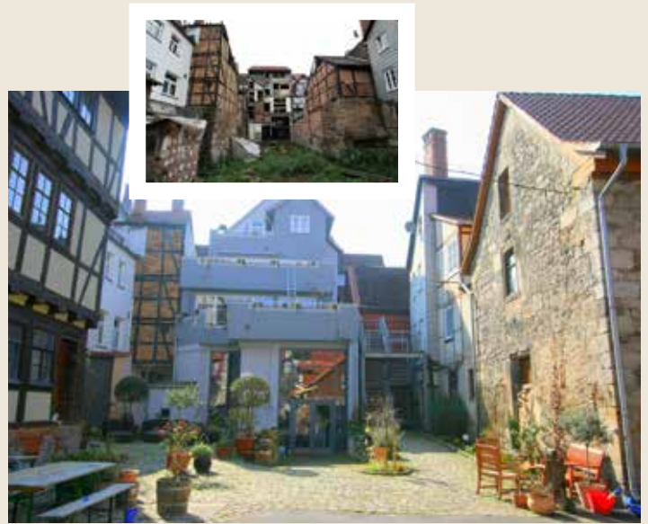
Der Innenhof vom ehemaligen Eisen-Meurer Geschäft in Hann. Münden wurde auch liebevoll saniert.
