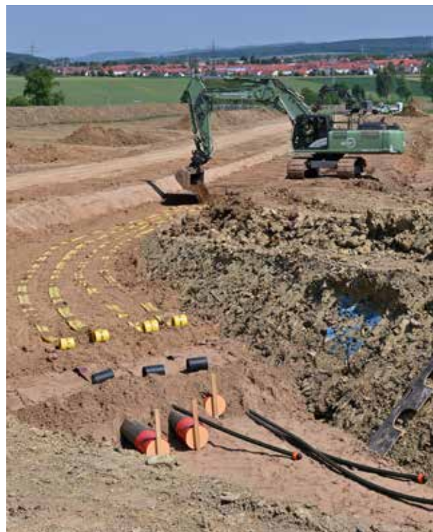
Der Kabelgraben besteht aus nebeneinander liegenden Leerrohren, durch die nach Rückverfüllung die eigentlichen Kabel gezogen werden.
