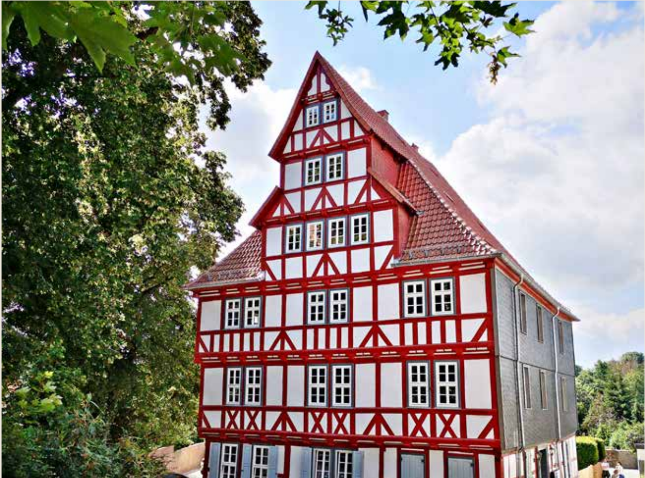
Das Gerodsche Haus in Duderstadt wurde aufwendig saniert
