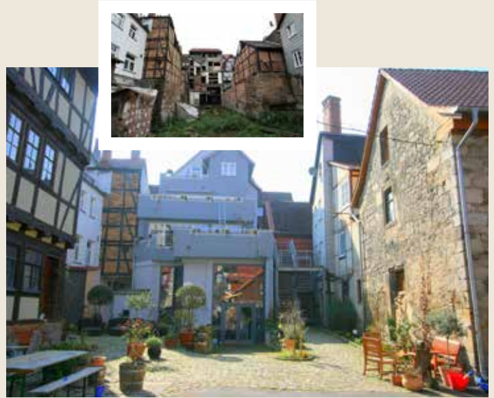
Der Innenhof vom ehemaligen Eisen-Meurer Geschäft in Hann. Münden wurde auch liebevoll saniert.
