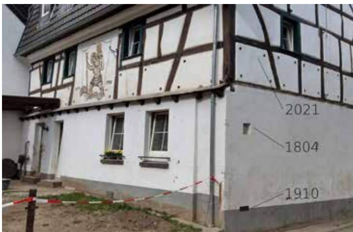
Haus in Walporzheim im Ahrtal mit Hochwassermarkierungen von 1804, 1910 und 2021.
