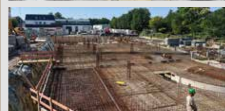
Die Rohbauarbeiten schreiten planmäßig voran.
