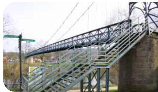
Im September beginnen die Sanierungsarbeiten an der Mündener Hängebrücke.
