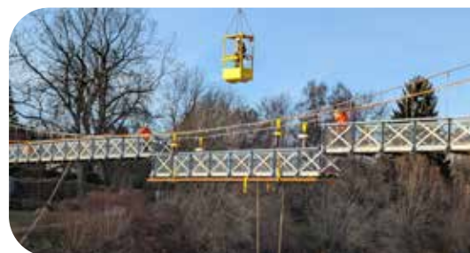
Anfang Dezember wurde das Tragwerk der Hängebrücke abschnittsweise demontiert
