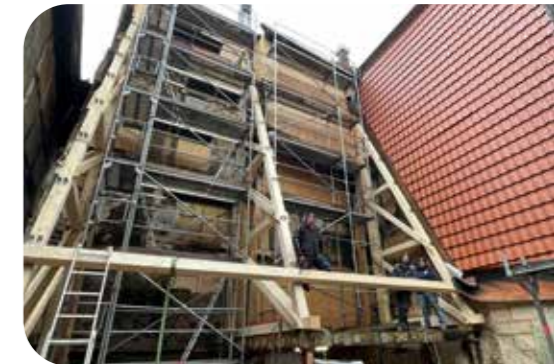
Die Firma Kuß Bau GmbH wurde damit beauftragt, das Bestandsgebäude dauerhaft zu sichern und einen Wetterschutz anzubringen.
