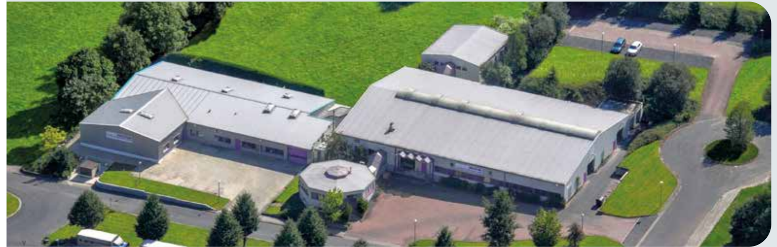
Luftaufnahme vom Unternehmenssitz im Industrie- und Gewerbegebiet Thielebach-Süd in Volkmarshausen
