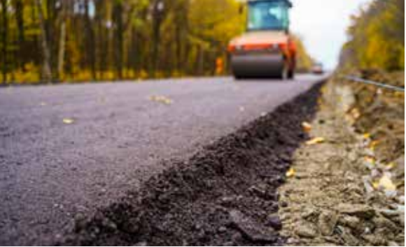
Arbeiten an der B80 und der Anschlussstelle zur A7 werden im März fortgesetzt. Symbolbild: Freepik
