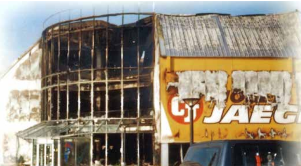
Auch von außen zeigte sich das ganze Ausmaß der Katastrophe: Das Möbelhaus in Oberdorla war durch das Feuer schwer beschädigt. Für Bernd und Gül Jaeger bedeutete der Brand einen tiefen Einschnitt – zugleich aber den Beginn eines mutigen Neubeginns.
