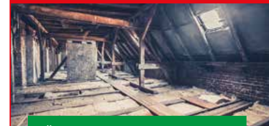
DÄMMUNG OBERSTE GESCHOSSDECKE
