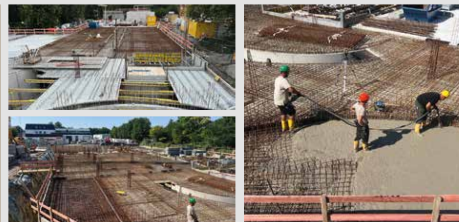
Die Rohbauarbeiten schreiten planmäßig voran.
