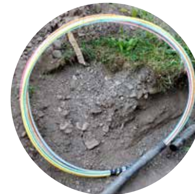
Glasfaserleitungen die in ein Schutzrohr gezogen wurden. Foto: Bernd Jackisch
