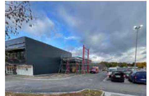
Die letzten Arbeiten laufen, die Neueröffnung ist für den 27. November vorgesehen.
