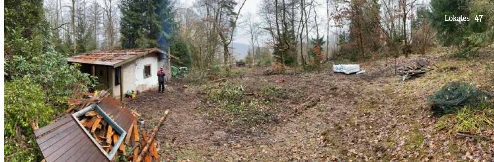
Hier entsteht eine neue Waldkita in Bonaforth.
