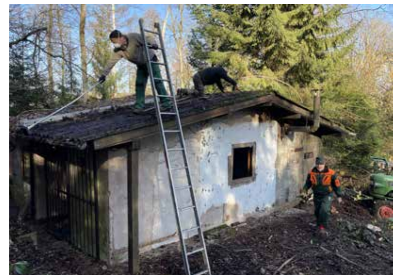
Aufräumarbeiten als Grundlage für die neue Kita.
