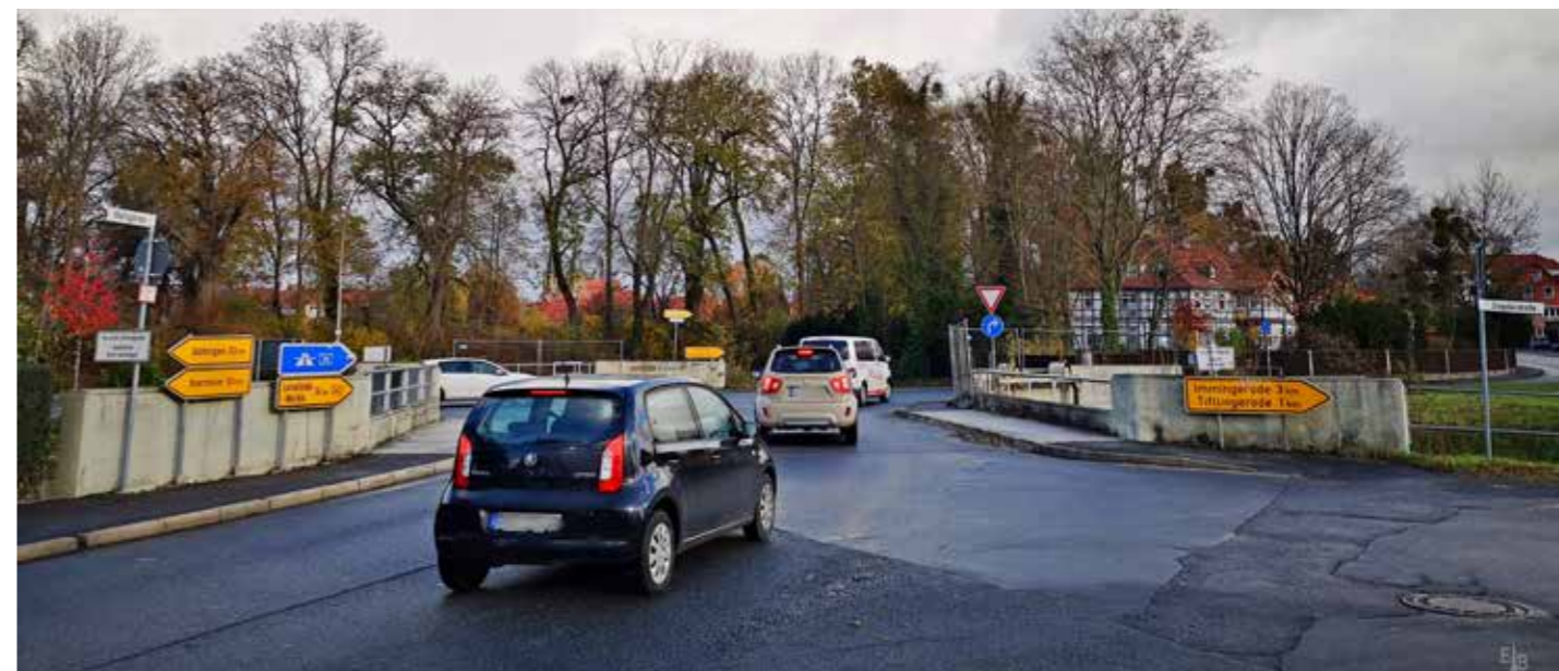
Die Baustelle am Schinderanger wird zum Nadelöhr für Fußgänger und Radfahrer
