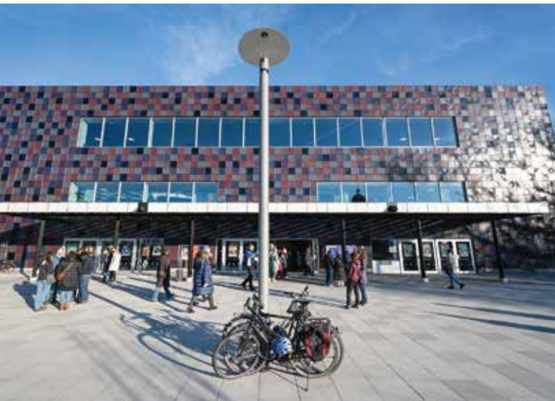
Historische Front der Stadthalle Die 50 x 50 cm Kacheln blieben erhalten.
